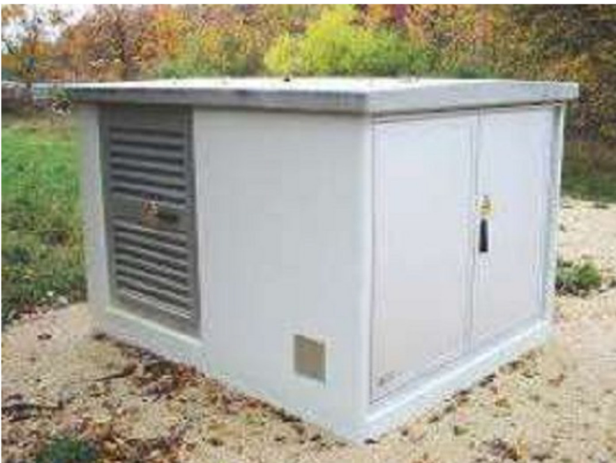
Abbildung 3 Trafostation
